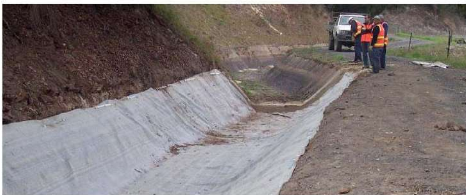
Строительство дренажного водоотвода автомобильного шоссе, г. Сочи
