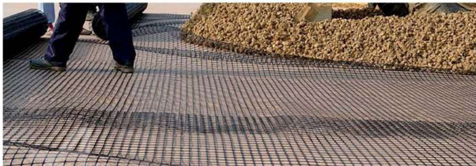
Строительство коттеджного поселка, г. Сочи
