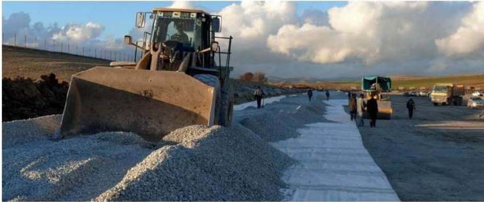
Строительство объездной дороги М60, Хабаровский край
