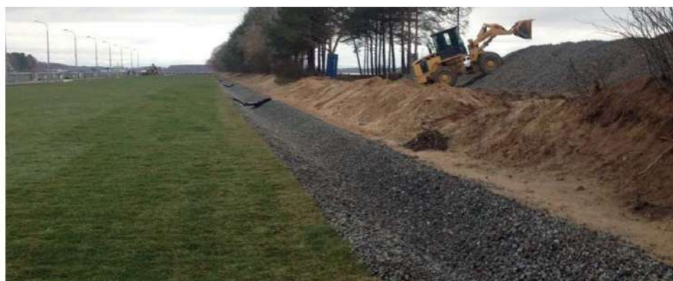
Укрепление береговой линии водохранилища, каскад Верхневолжских ГЭС Русгидро
