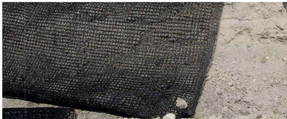
Защита склонов от эрозии на участке автодороги «Северный маршрут» Пермь-Сургут
