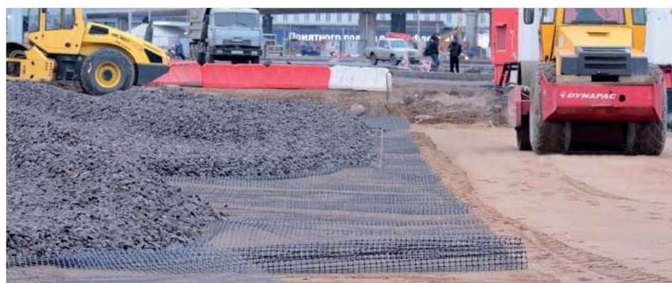
Строительство подъездных путей промышленного парка «Грабцево», г. Калуга
