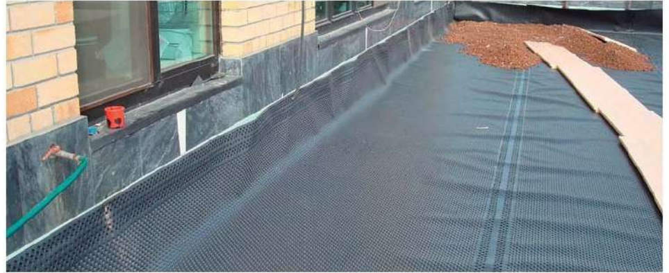
Гидроизоляция профилированной геомембраной, Курск
