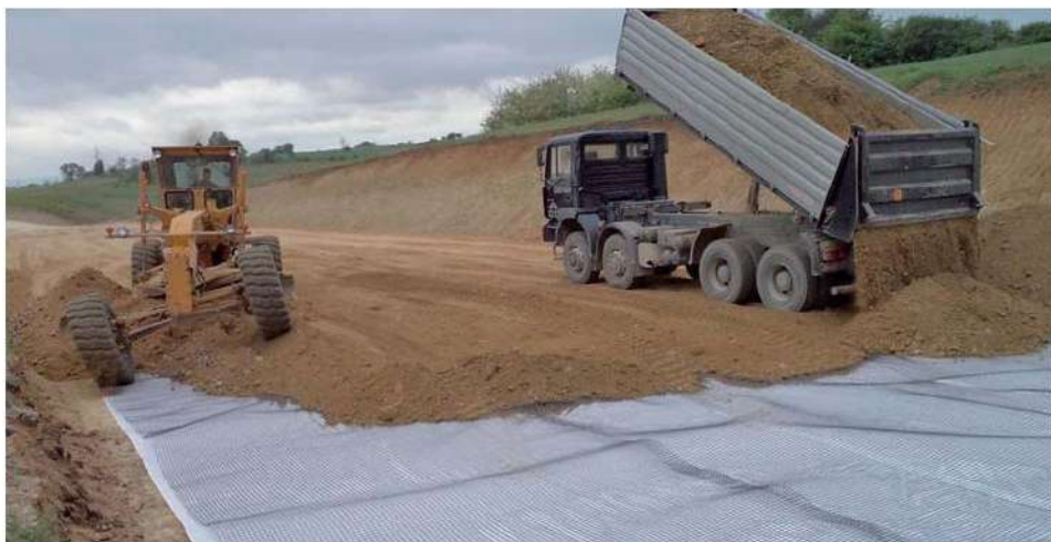
Укладка геокомпозиата при строительстве дороги, г. Уфа
