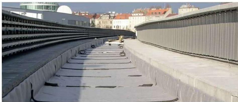
Строительство транспортной инфраструктуры объектов Универсиады, Казань
