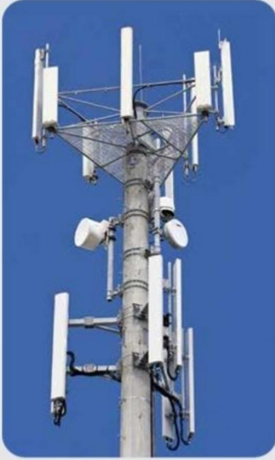
GSM ve telefon santrallerinin birbirleri ile ya da cep telefonlarının haberleşmesi için kullanılan her türlü anten direkleri civatalı veya kaynaklı olarak tasarlanabilmekte ve imal edilmektedir.
