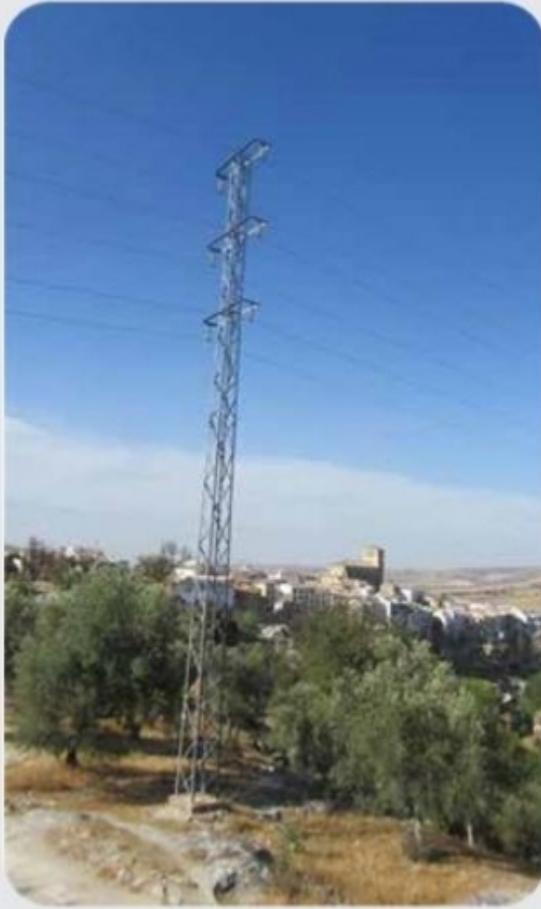
Galvanizli Kaynaklı ve Galvanizli Civatalı Şehir Şebekesi Direkleri: üzerinde sadece Alçak gerilimin bulunduğu AG direkleri ve üzerinde Alçak Gerilim ve Orta Gerilimin beraber bulunduğu MÜŞTEREK direkler olarak iki guruba ayrılır. Ayrıca her grup kendi arasında A tipi ve kafes direk olarak iki ayrı guruba ayrılır. Bu direklerin boyları buz yükü bölgelerine göre değişim göstermektedir. Ayrıca dağıtım hattındaki direkler arası mesafeye göre kısa tipleri ve normal tipleri bulunmaktadır.
