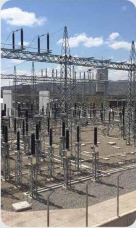
Şalt sahası; güç trafoları, baraları ve diğer bütünleşik elemanları ile elektrik üretim, iletim ve dağıtımın yapıldığı tesislerdir. Şalt sahalarında trafolar aracılığıyla elektrik alçaltılıp veya yükseltilecek istenilen iletim seviyesine getirilir aynı zamanda bunun dışında da önemli fonksiyonları gerçekleştirilir. Kısaca elektrik enerjisini toplamaya veya dağıtmaya yarayan birimlerdir.
