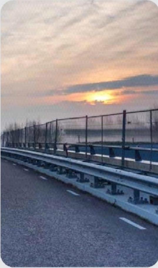
**Otoyol Korkulukları :** Sürücü ve yolcuları yol kenarlarındaki engellerden, yayaları ve tesisleri de taşıtlardan korumak amacıyla, karayollarının büyük çoğunluğunda, otoyol korkuluklar kullanılmaktadır. Yol kenarı güvenlik sistemleri olarak oto korkuluklar, hem düşük maliyetli hem de yüksek performanslı olarak tasarlanmış olup can ve mal güvenliği koruyan ve riskleri asgari oranda düşüren sistemlerdir.
